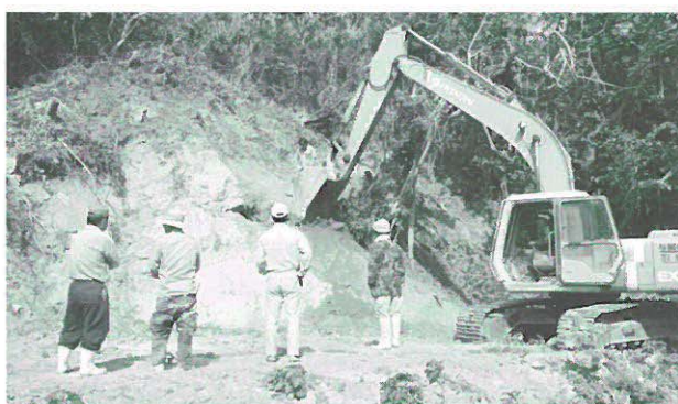
写真28. バックホウで掘削
