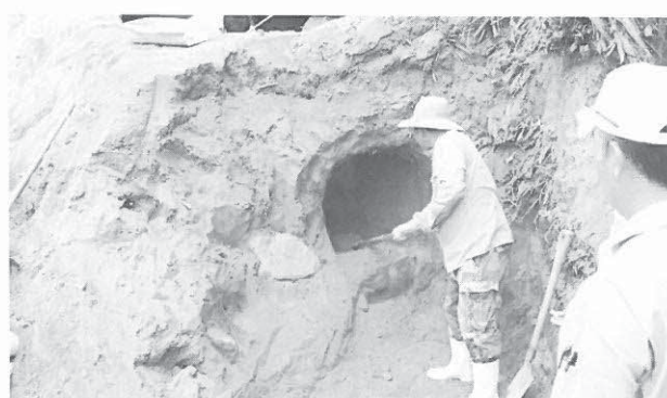
写真36. 入口掘削
