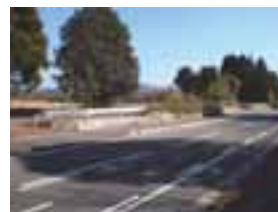
中山錦川遺跡C地区(6号道路及び付属施設)付近
