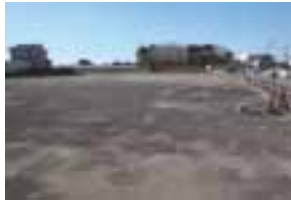
西側格納庫前準備線のコンクリート舗装
