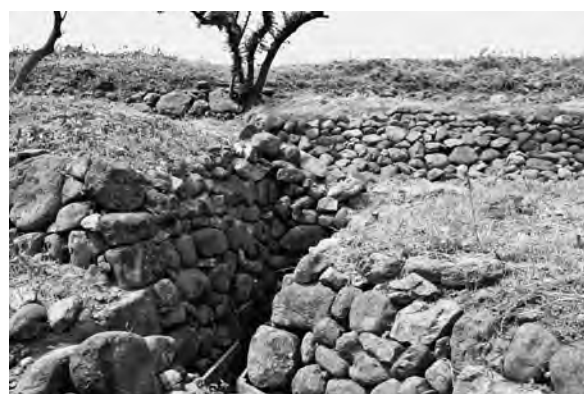
写真 32 河下台場・西台場暗渠
