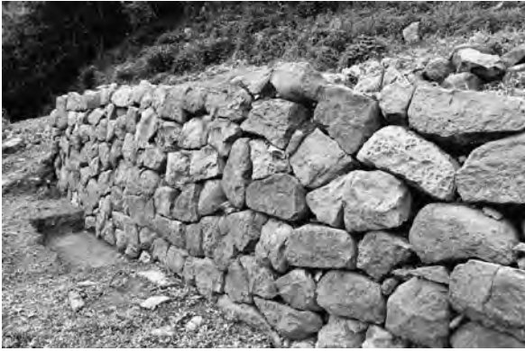
写真 29 網屋浜台場東側石垣
