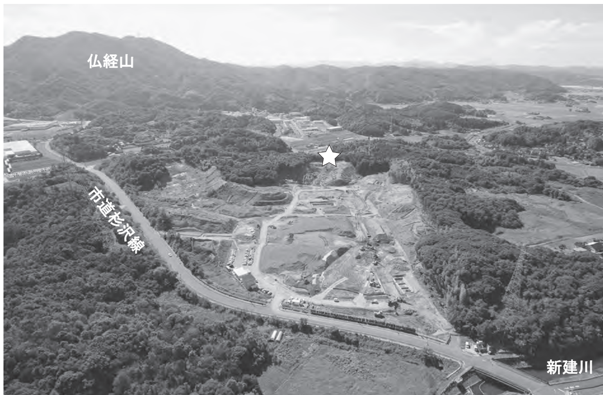
図2 杉沢遺跡全景（北から） ☆の位置で道路遺構検出
