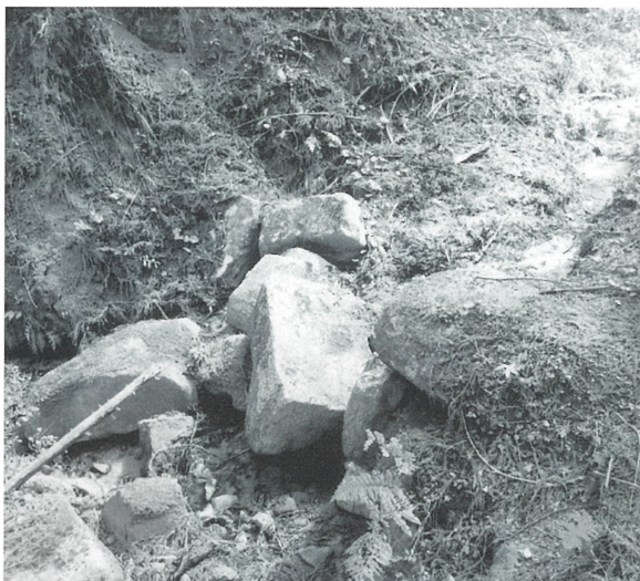
写真4 東側水門遺構（北より）
