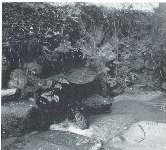
写真6 西側水門遺構の南側端部（南より）
