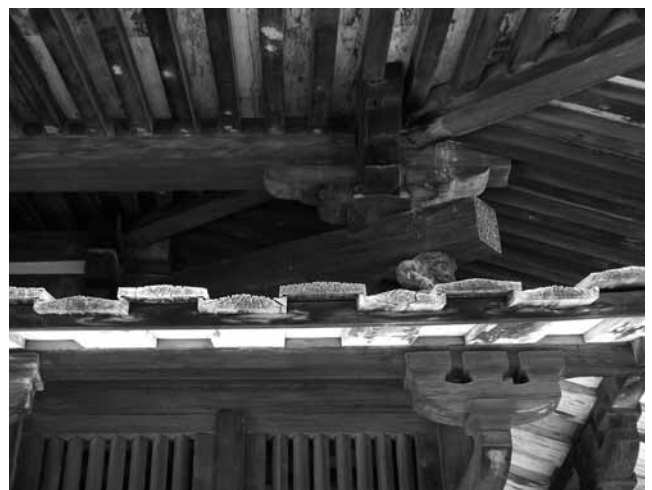
写真4 法隆寺五重塔裳階大和葺
