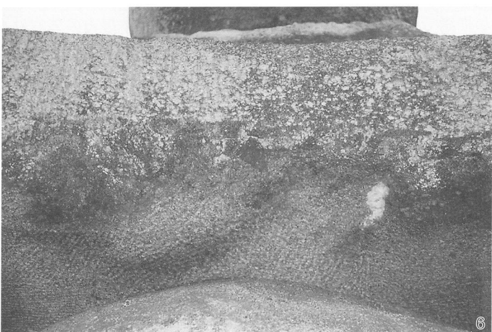
5. 石清水八幡宮五輪塔〔京都府八幡市〕鎌倉時代 6. 同・火輪下部先Aタイプ矢穴列痕
