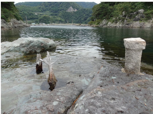
兵庫県新温泉町居組の繫留杭 左は木杭（上部は細っているが、基部は木材が残る）、右は石杭（花崗岩）
