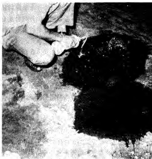
第4図 白色析出物の薬剤による処理状況
