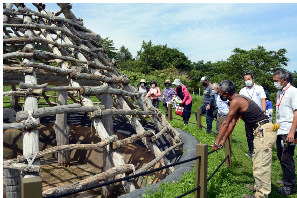
図 4.3 発掘調査成果にもとづいて、クリ材で躯体を復元した竪穴住居
