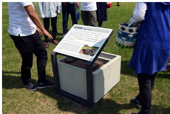
図 4.15 垣ノ島遺跡の解説板は地中に基礎を打たず、解説グッズ収納を兼ねたコンクリート柵で固定されています
