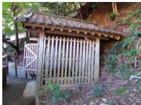
写真 3-35 西教寺客殿庭園脇の取水場
