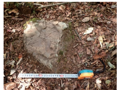
写真13 柱受け部を加工した礎石
