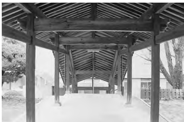
渡り廊下内部（北西から）
