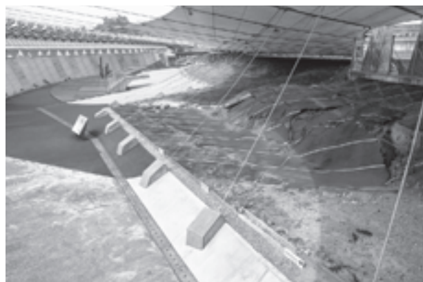
図54 断層がずれて高低差が生じた運動場
