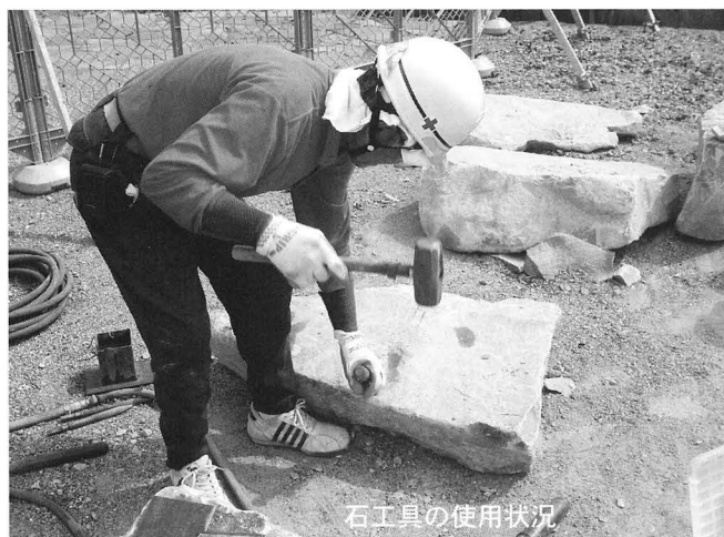
甲府城の石垣補修工事で使用している道具
