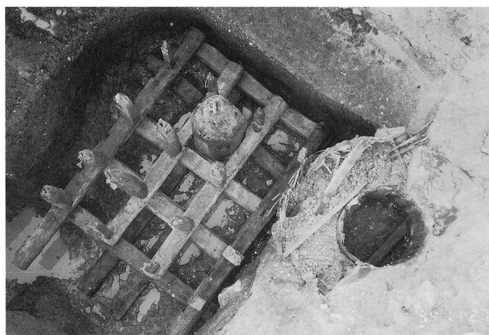
図7 地中梁と男柱と遺構（左）と桶状遺物（右）の検出状況
