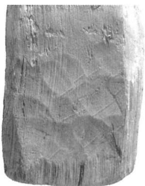
写真6 柱材1のハツリ
