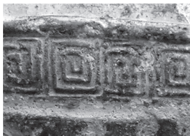
1 突帯貼り付け部
