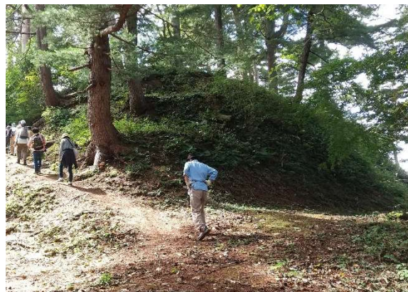
図 3-8 高原諏訪城 主郭を見上げる
