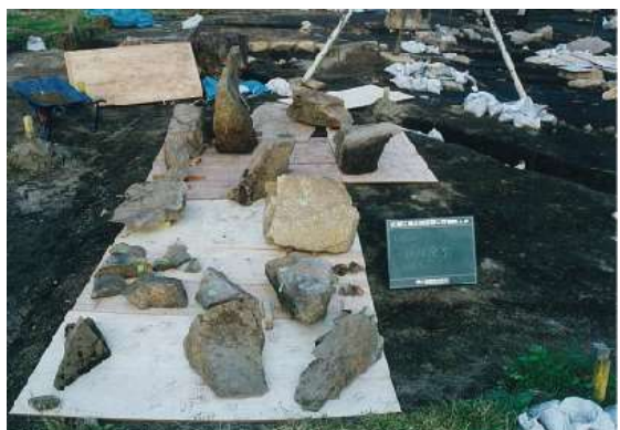
図 14-2 解体した様子
