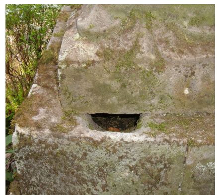
写真 27 基礎 礫石経投入口
