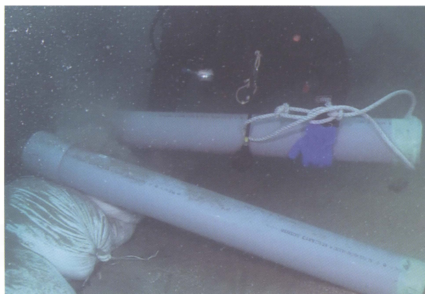
図2 潜水士による埋め戻し作業の様子
