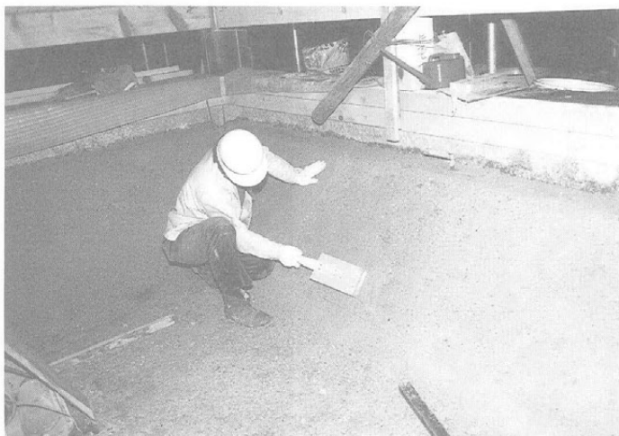
写3 能舞台床下漆喰叩き施工
