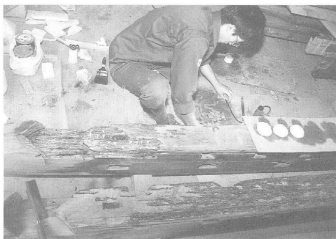
写4 当初材腐朽部の樹脂加工による補修
