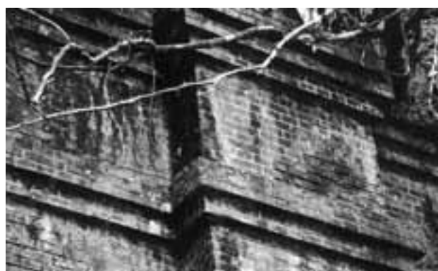
写真図版 16 瀧ノ澤隧道 笠石・帯石部 (分類 (C))
