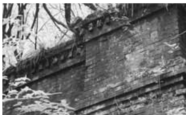
写真図版 14 猿羽根第三隧道 笠石部歯飾り (分類 (A))
