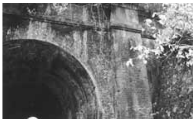
写真図版 13 金堀隧道 笠石部歯飾り (分類 (A))
