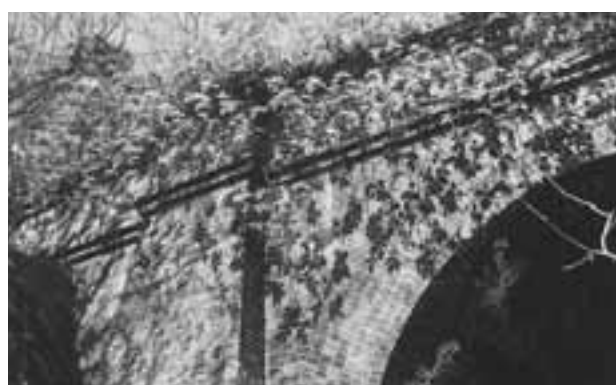
写真図版 17 権現山隧道 坑門アーチ部6枚巻
