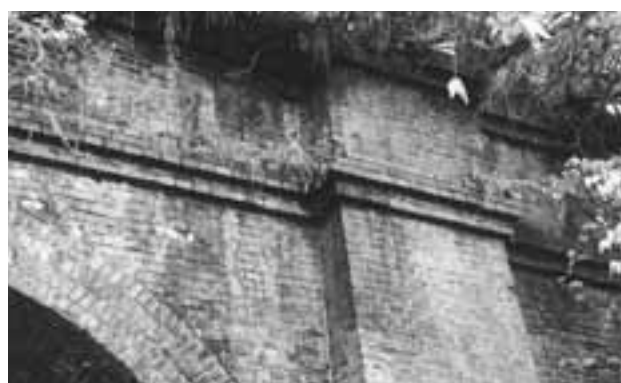
写真図版 15 猿羽根第一隧道 笠石・帯石部 (分類 (B))
