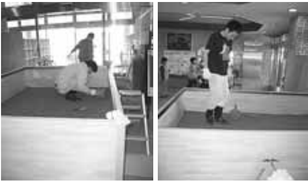
第12図 ローム土充填状況
