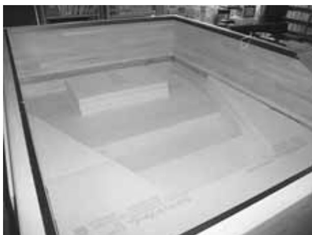
第8図 断熱材の下地完成
