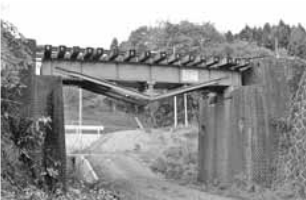
写真14 界川橋梁(南から) フィンク補強の橋桁
