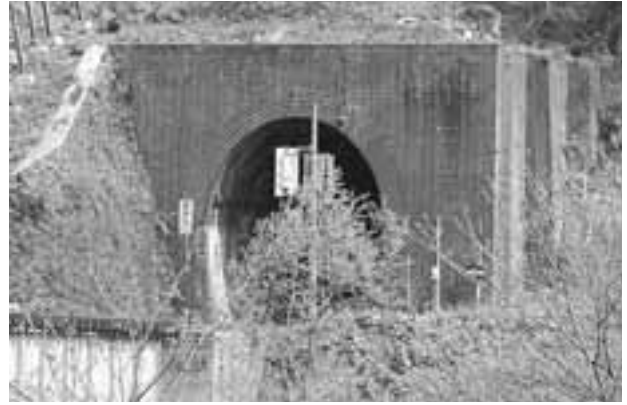
写真9 腹巻山隧道（余目方）側面に柱状の構造物
