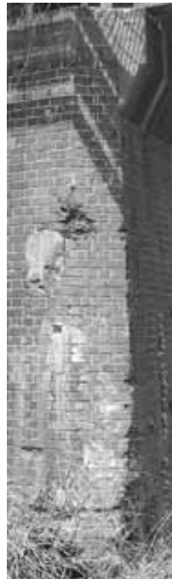
写真32 内又架道橋 橋台 隅部の切り落し面に見られる装飾的な煉瓦積み（左・余目方、右・新庄方）
