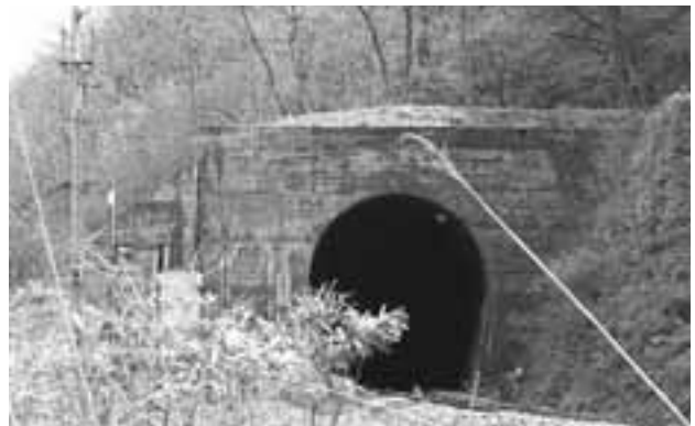
写真4 板敷山隧道（余目方）山側の下部に煉瓦部分が残る。
