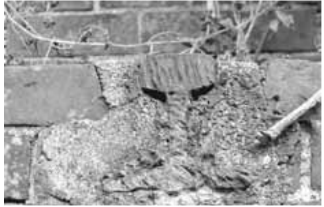
写真13 (旧) 名称未確認架道橋 橋台 廃レール埋め込み状況
