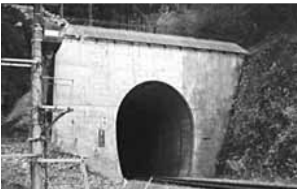
写真5 沓喰隧道（余目方）北側側面に煉瓦部分が残る。
