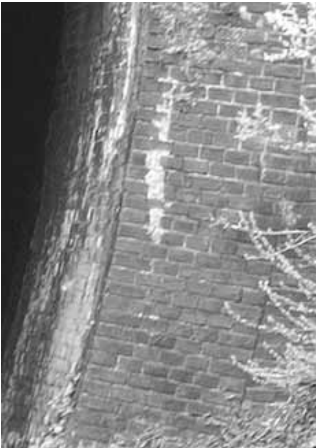
写真27 板敷山隧道余目方坑門側壁部の「化粧迫持」
