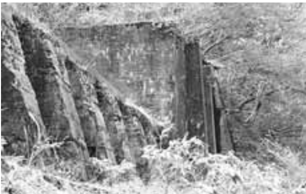
写真3 板敷山隧道（新庄方）側面に柱状の構造を有する。
