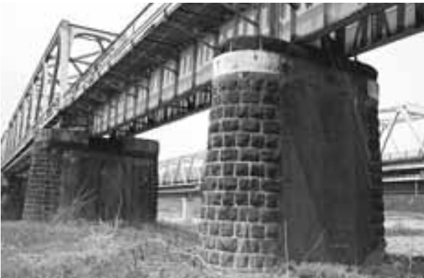
写真16 第一最上川橋梁 規模の異なる2種類の橋脚
