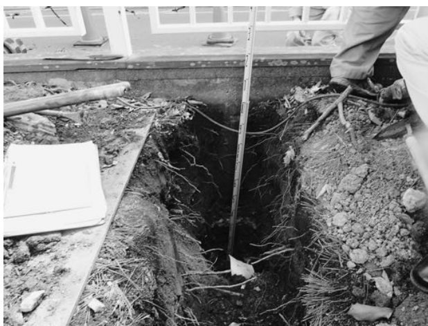
図 11 (新蔵) ガス管埋設工事
