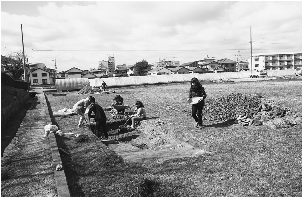
写真2 作業風景 東より
