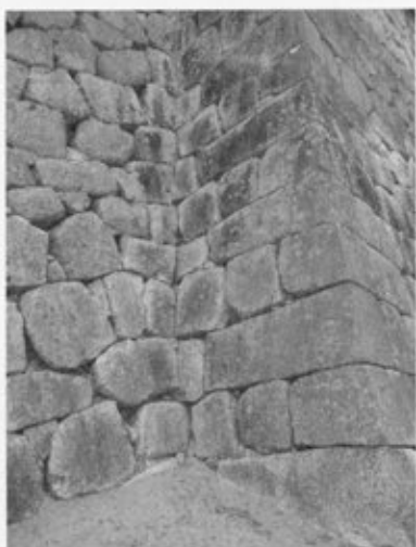
写真29 本壇天神櫓台石垣入角部（南東より）
