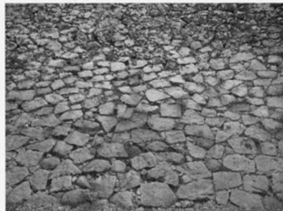
写真6 本丸周辺築石部（北より）
