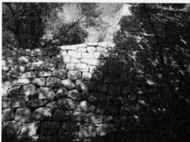
写真17 築石部（南より）
