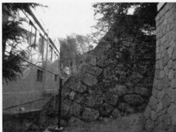
写真3 隅角部（北より）
