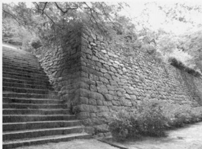
写真30 西山興隆寺石垣（南東より）
