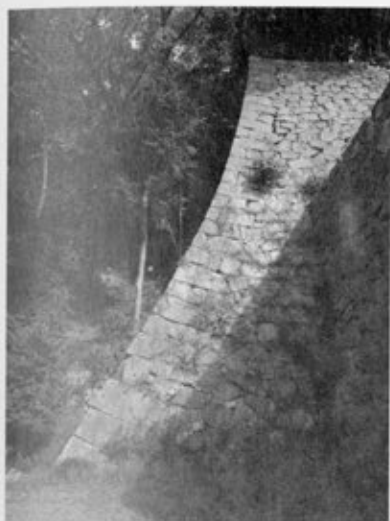
写真7 二之丸周辺隅角部（南より）
