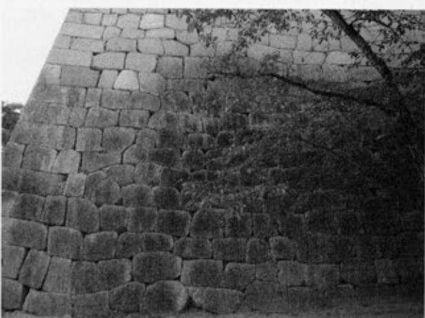
写真19 築石部（南より）
