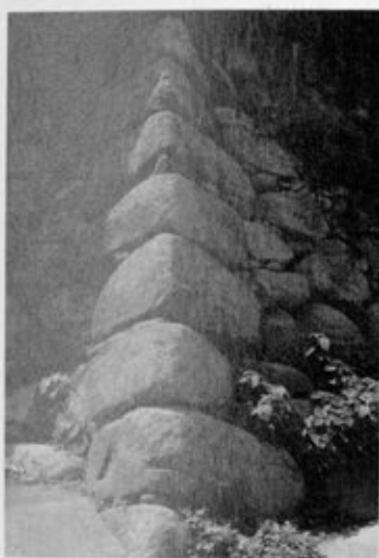
④鉄門石垣隅角部（北より）
