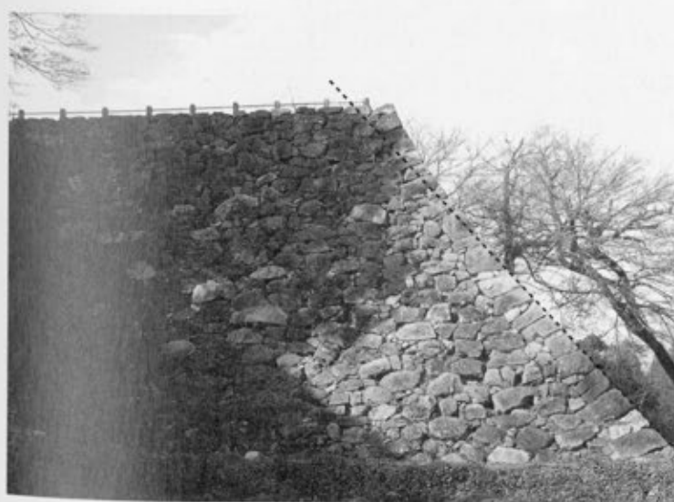
⑤小天守台石垣（南面）
