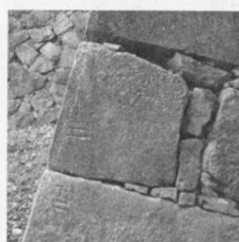
⑥隅角部の表面調整 (南東隅角部)
