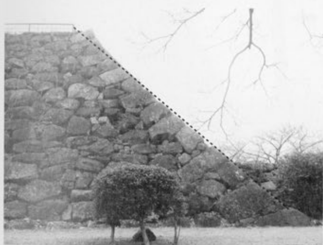
③天守台南東隅角部（南面）
