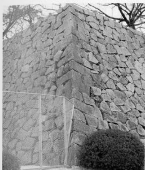
①二の丸萬櫓下隅角部（北東より）
