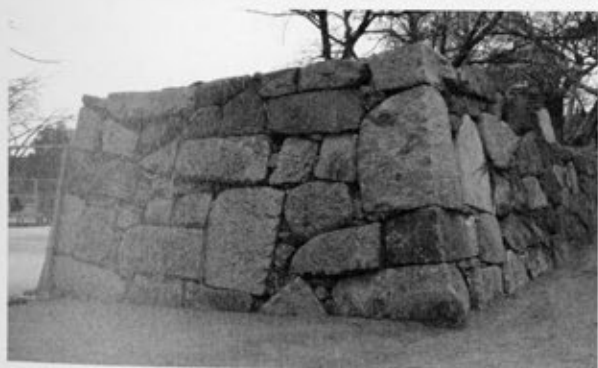
⑤扇坂門石垣（北より）
