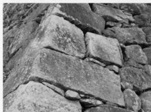
④ 同上③の拡大（南東より）
