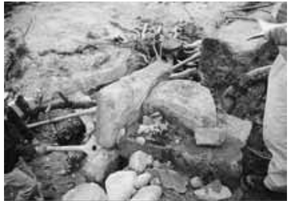
写真25 パネル石による修理
