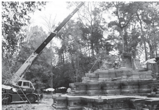
カンボジア・アンコール遺跡群内の西トップ遺跡における修復作業の様子
