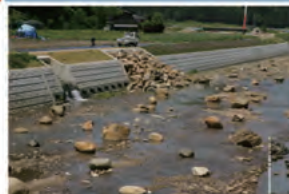
巣穴ブロックと巨石積護岸
