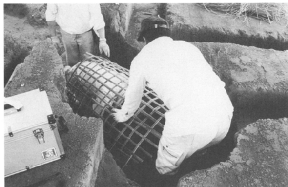
図6 天井骨組設置作業（2号実験窯）
