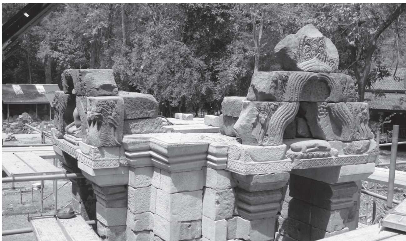
図16 破風組み上げ状況 (南東から)
