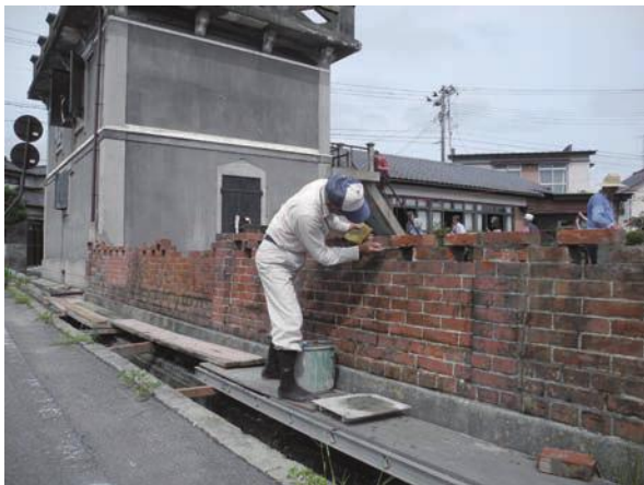
もと同じように透かし積みで復旧。一段段数を低くした
