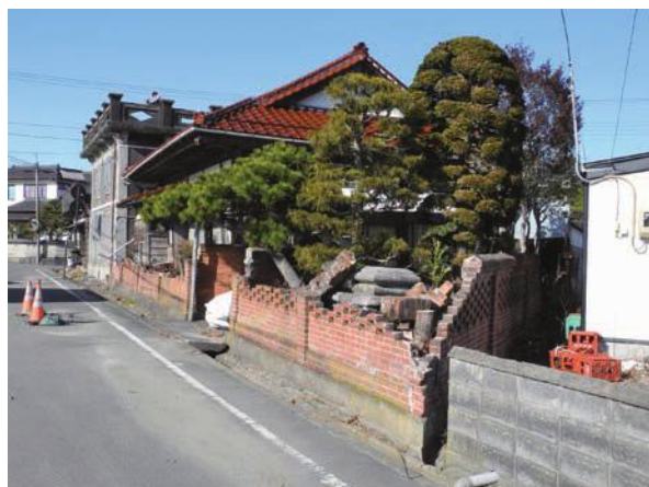
修復前 東日本大震災時に塀上部が落下した
