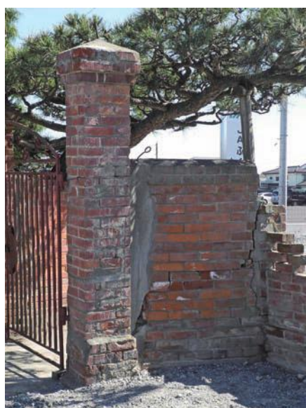
修復前 袖塀への取付部に亀裂が入っていた
