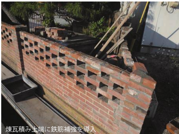
もと同じように透かし積みで復旧。一段段数を低くした
