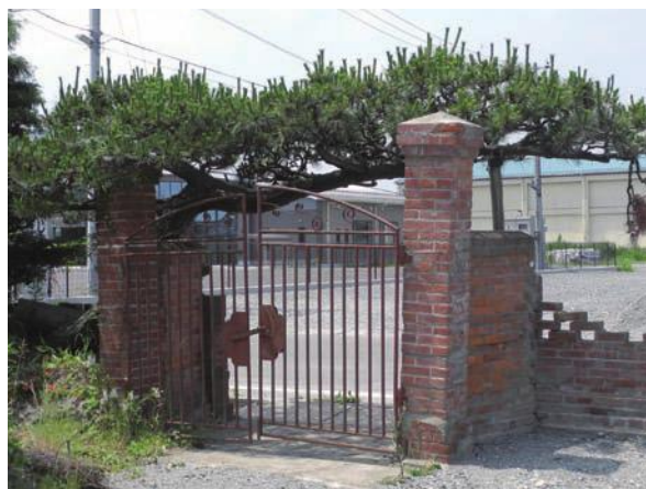
修復前 門柱は大きく傾いていた（高さ 1 m に対し 40 ミリ、北方向）。鉄扉は板倉鉄工所製作
