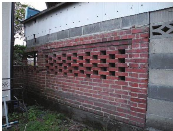
透かし積み 7 段と笠木からなる。隣地から見る（後設のコンクリートブロック造の「小屋」はその後撤去）
