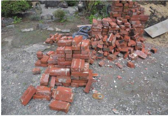
煉瓦は目地材をはつり落として再利用
