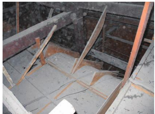
小屋裏に残る折上げ格天井（当初天井の裏より）
