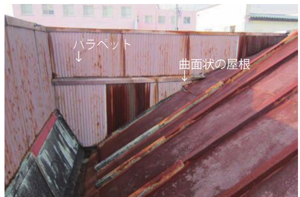
正面パラペット裏に曲面状の屋根が残る。 屋根葺替工事の調査により判明
