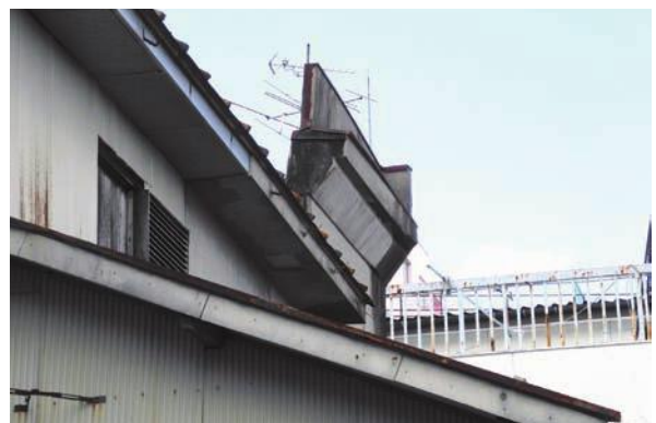
北面東隅に軒蛇腹の断片が残り、当初の朝日座の姿を伝えている
