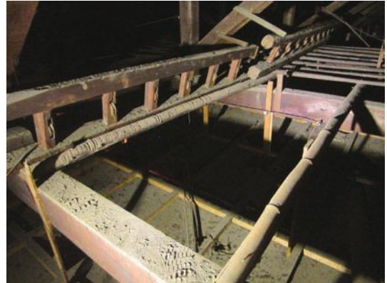
小屋裏に残る舞台装置の滑車。滑車前の固定された丸太には、縄の擦れた跡が深く残る
