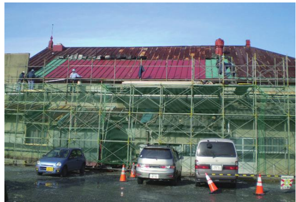
屋根葺替工事の様子
