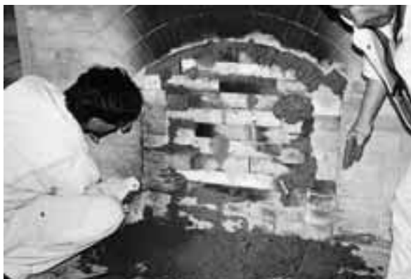
写真12 焚き口閉塞作業風景 2
