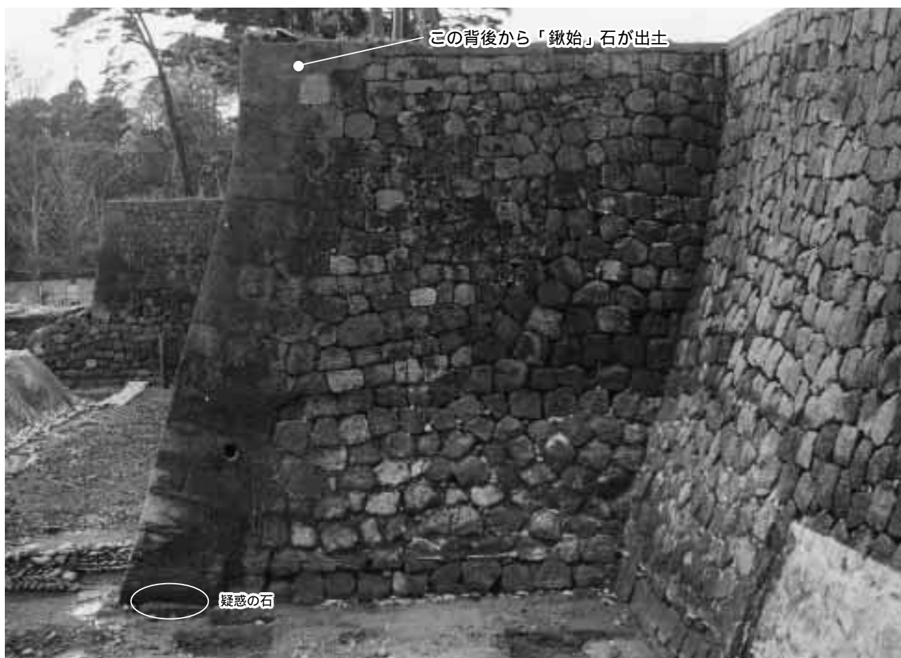
写真2 五十間長屋台北面石垣（宝暦13年の改修ラインが見える）
