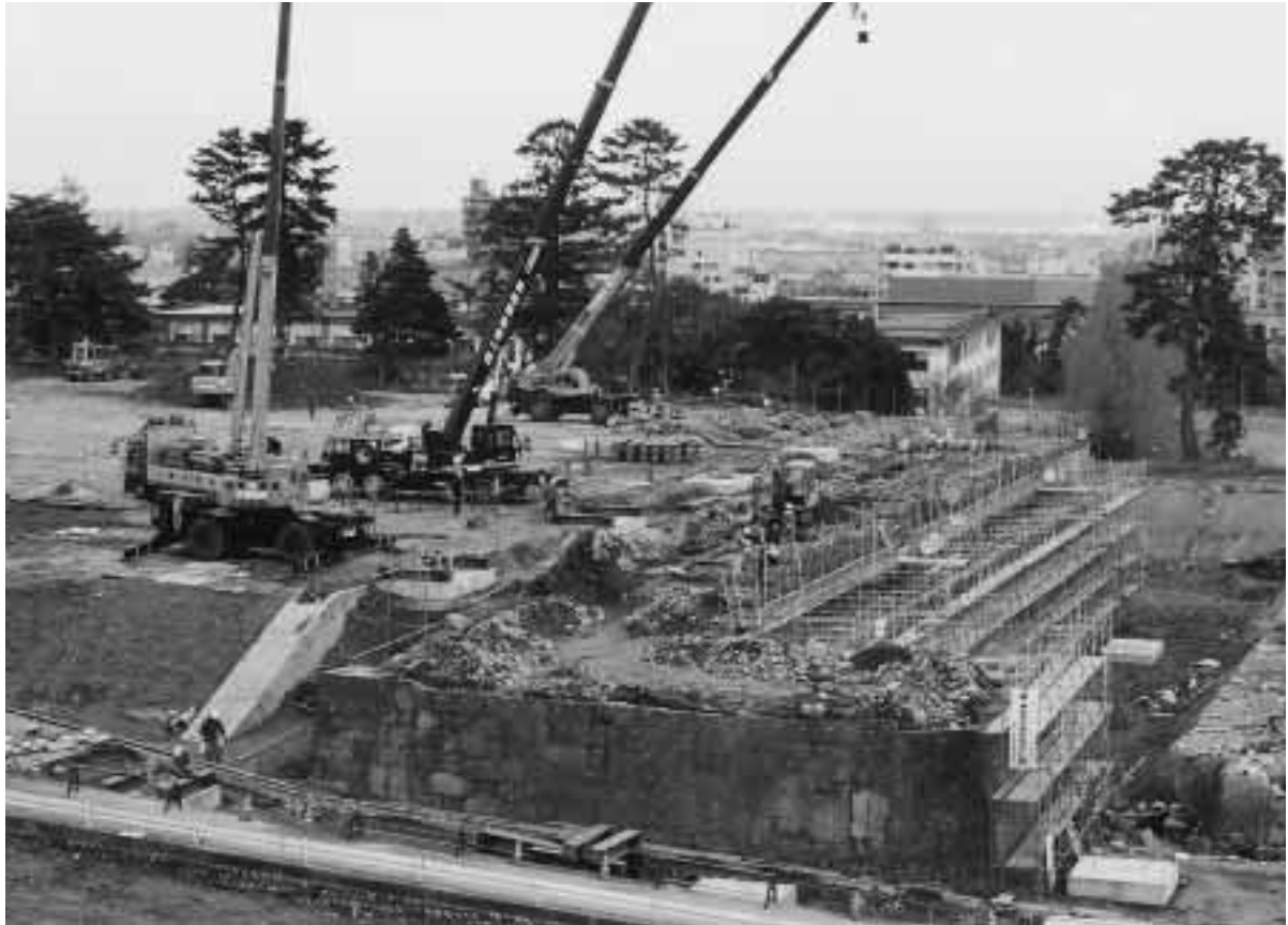
「菱櫓・五十間長屋・橋爪門続櫓台」の石垣解体調査風景
