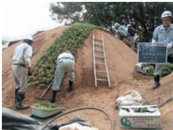
Fig.134 コグマザサ施工状況
