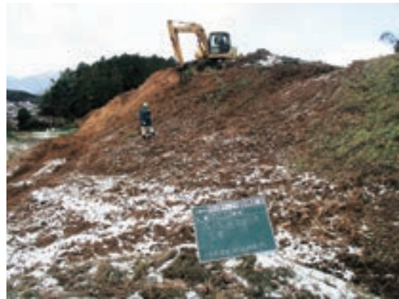
Fig.68 南西部竹伐根施工状況
