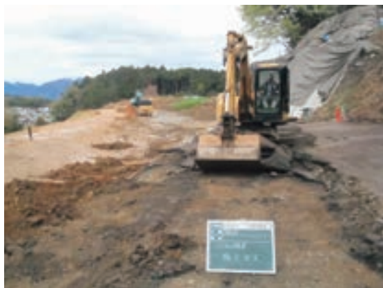
Fig.76 アスファルト舗装撤去状況
