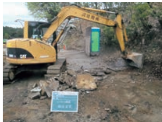
Fig.77 コンクリート舗装撤去状況
