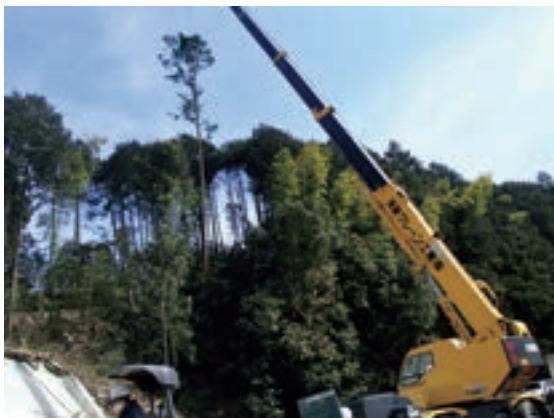
Fig.71 クレーンを用いた伐開作業
