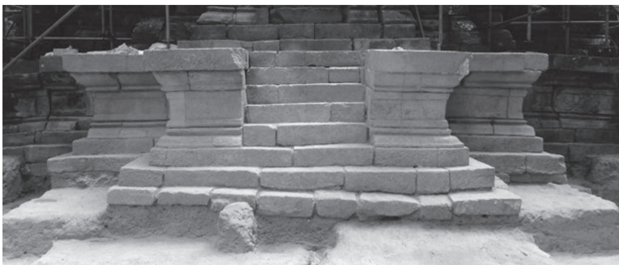
第37図 中央祠堂南階段 修復後
