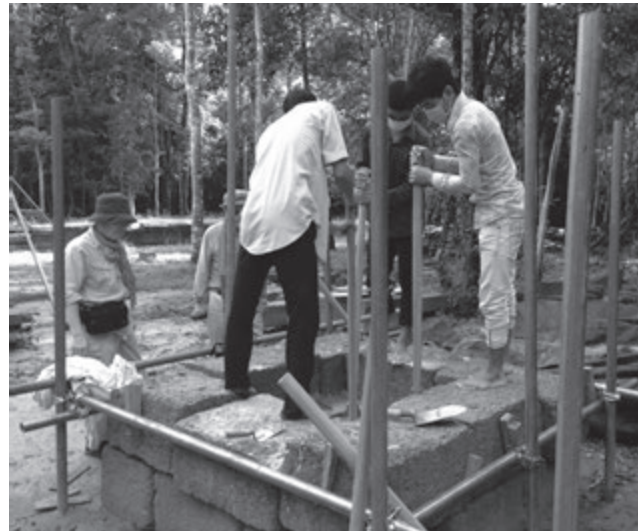
第2図 基壇土試験盛土
