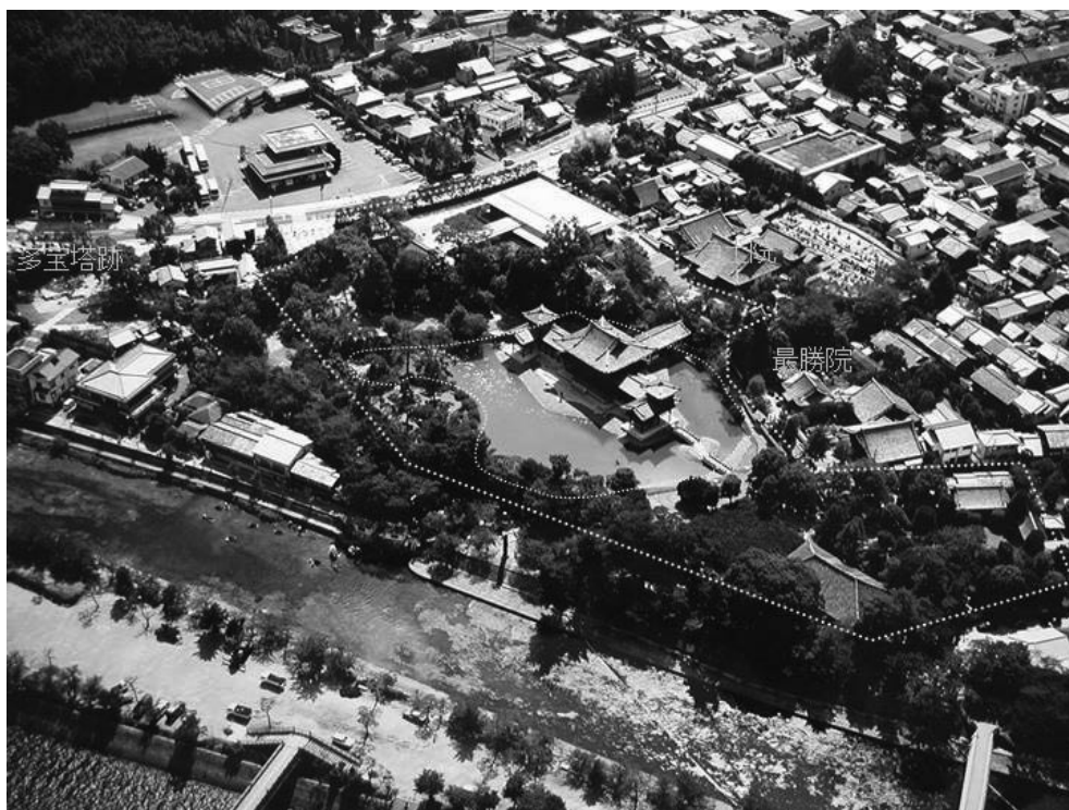
図－7 平等院庭園 上空写真
