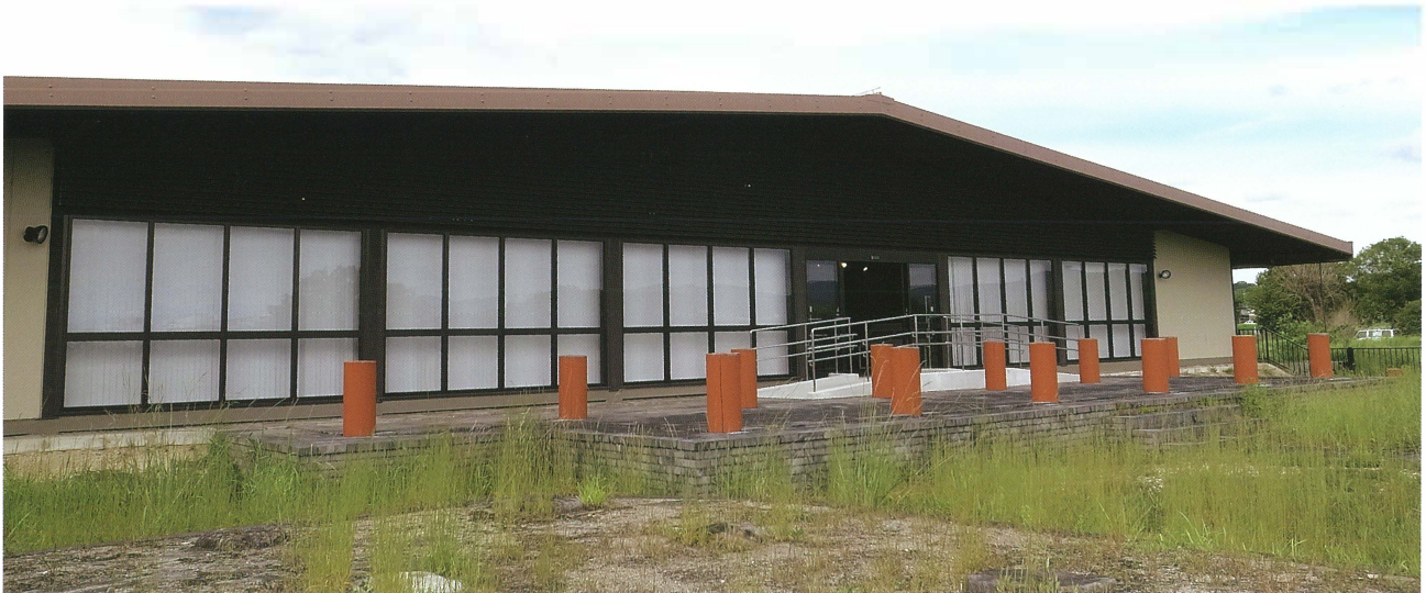
図1 平城宮跡遺構展示館外観（南西から）
