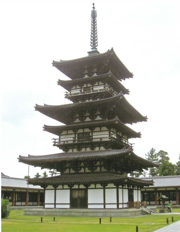
図 11 解体修理前の東塔（2009 年 海野聡氏撮影）
