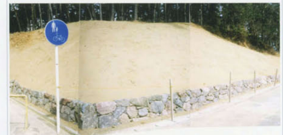
施 工 時 等 下部石積擁壁、上部 盛土整形完成後。 種子吹付工施工前。 (2000年1月)
