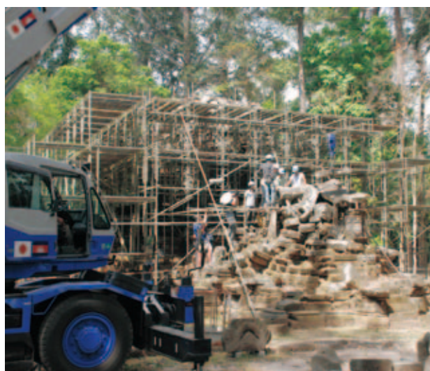
クレーンによる崩れかかった建物の解体修理
