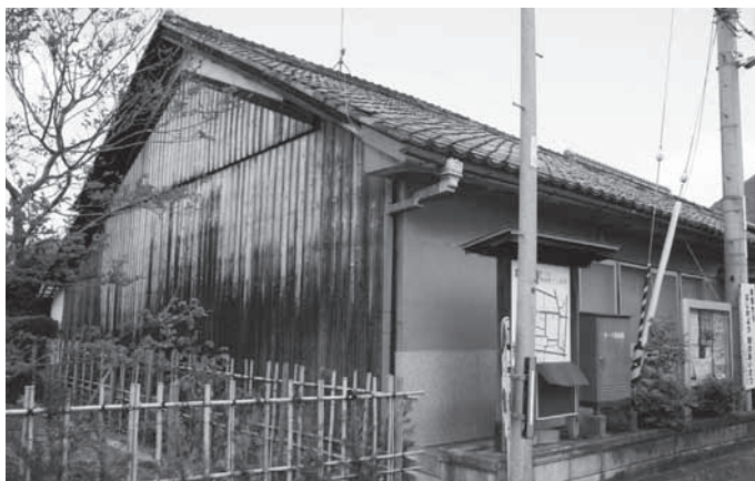
前田公民館南西側外観
