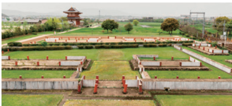
図63 兵部省（東）修繕工事前（2024年4月撮影）
